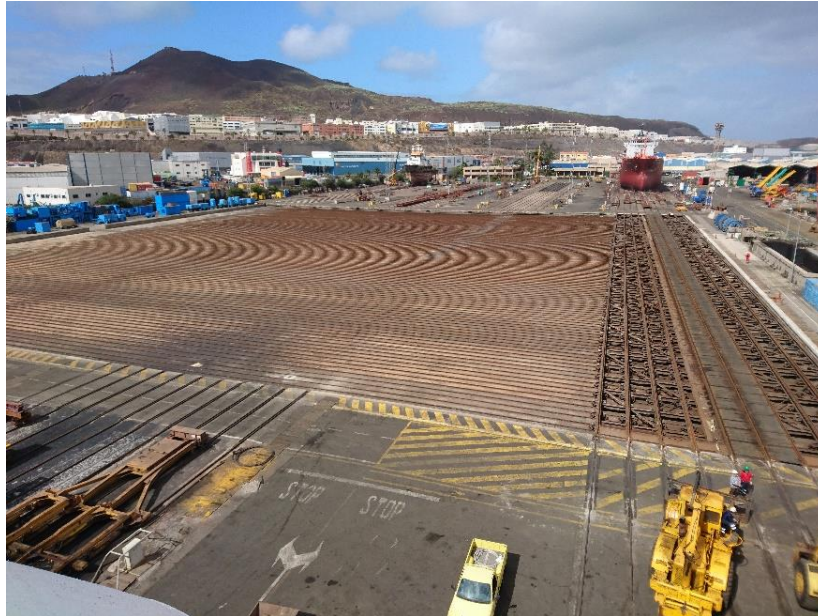
12. Zona de transferencia
