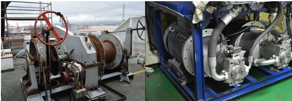
33. A la izquierda, mantenimiento a una maquinilla de proa. A la derecha, nuevas bombas instaladas en el sistema hidráulico
