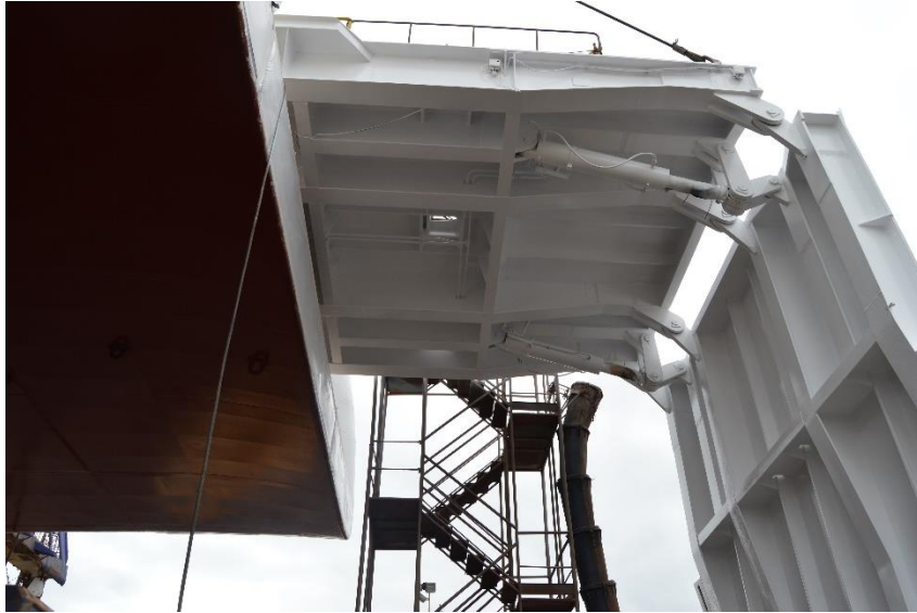
36. Rampa de popa una vez finalizado el trabajo de pintado.
