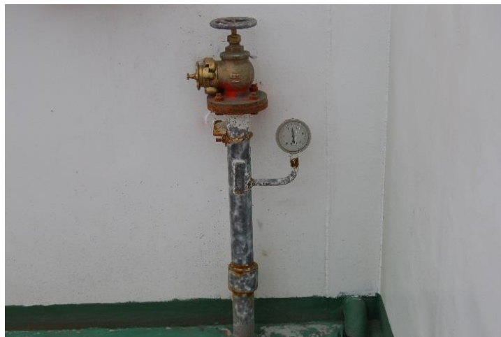
29. Hidrante saneado, cubierta exterior
