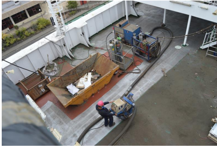
18. Chorro de arena en cubierta
