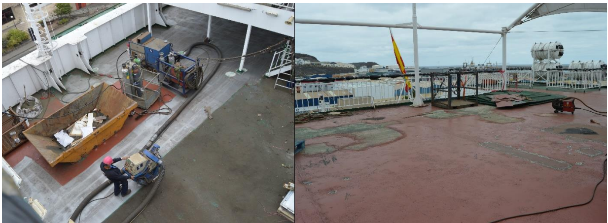
31. Limpieza con arena en cubierta y comienzo de trabajos de pintado
