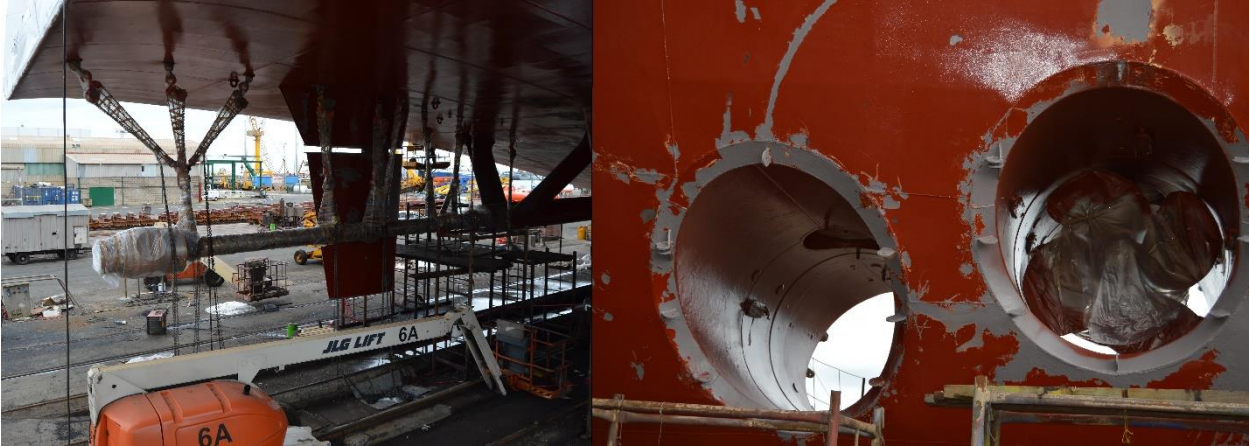
34. A la izquierda, proceso de sacar el eje de cola de babor. A la derecha, trabajos en ambas hélices de proa
