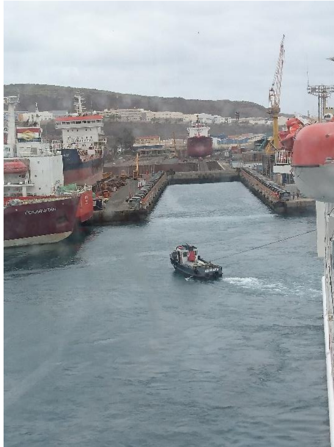
9. Vista inicial del Syncrolift en posición de bajada
