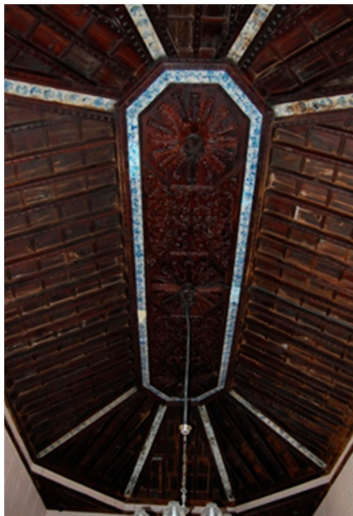
Figura 25. Techumbre mudéjar ochavada del salón principal de la Casa They (Santa Cruz de La Palma), sin policromar, con azulejos en la cinta del almizate y papel pintado en las limas moamares que dividen los faldones.
