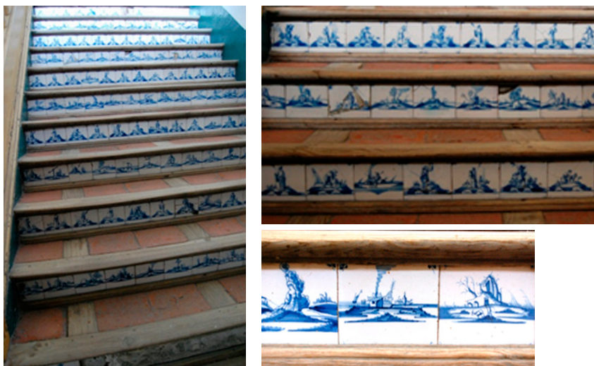
Figuras 29, 30 y 31. General y detalle de la escalera principal de la Casa Massieu (Santa Cruz de La Palma).
