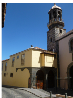
Figura 4. Convento de San Benito, con la portería antigua en primer término.
