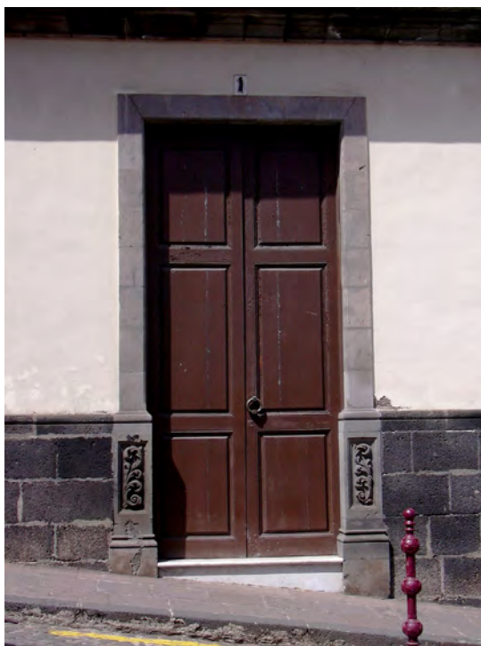
Fig. 5. Portada de la casa Díaz Flores en la que se aprecian los elementos extraídos de la portada jesuita.
