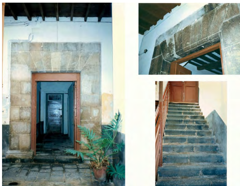
Fig. 14. Patio trasero de la casa Díaz Flores. Pueden verse las antiguas puertas de las sacristías y los escalones reutilizados.
