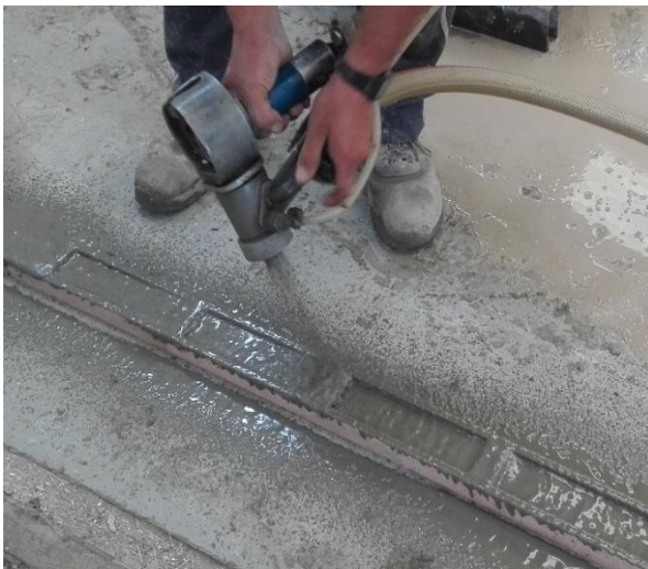
Figura 6.8. Proyección sin fibra de vidrio. [fuente propia].
