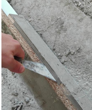
Figura 6.13. Desencofrado [Fuente propia].
