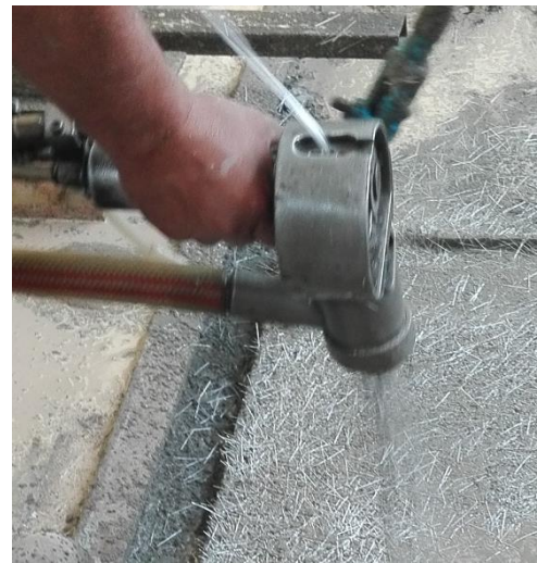
Figura 6.9. Proyección con fibra de vidrio. [fuente propia].
