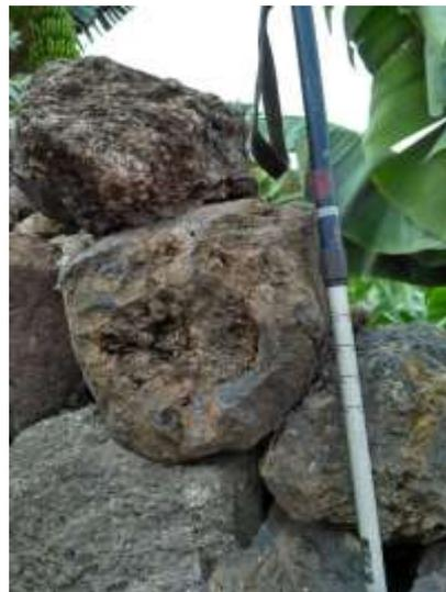
**Fig. 6-**Muro agrícola construido con bolas de acreción.
