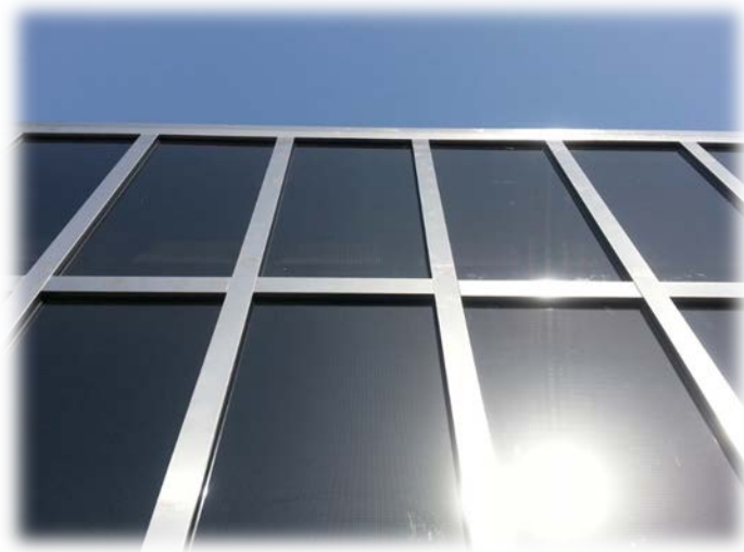
Ilustración 12. Paneles fotovoltaicos de CdTe.
