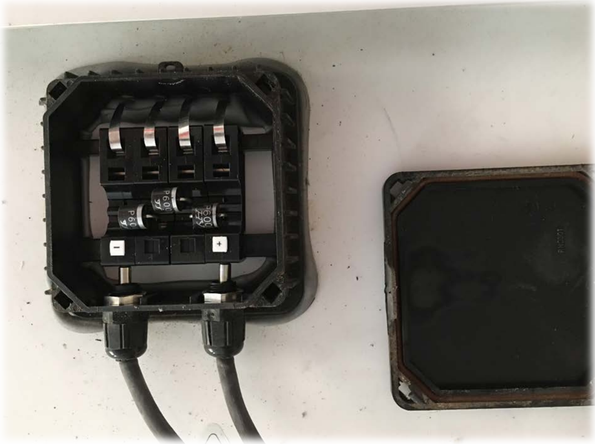
Ilustración 39. Desmontaje de la caja de conexiones del panel.
