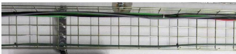
Figura 10. Canalización por bandeja perforada
