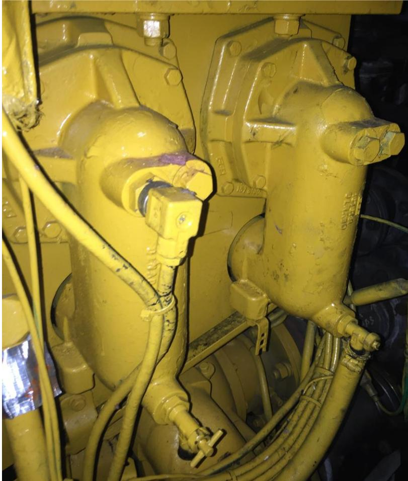
*Ilustración nº 33: Columnas Filtros (Vokes Simplex).
