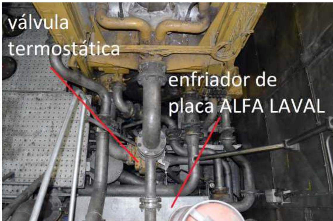
*Ilustración nº 31: Válvula termostática de aceite y Enfriador de Placas (Alfa Laval).
