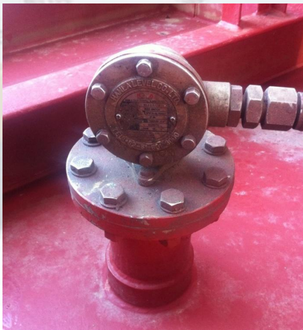
Imagen de la alarma Hi y Hi-Hi del tanque TC4E (Archivo: Alfonso Fortuny).
