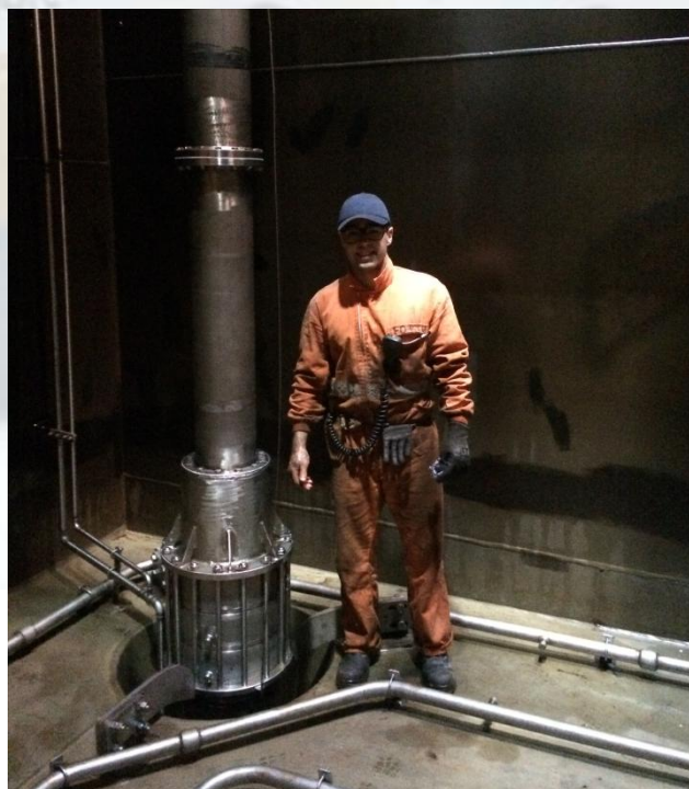
Imagen de la reparación de una bomba en una para técnica. (Imagen Alfonso Fortuny)
