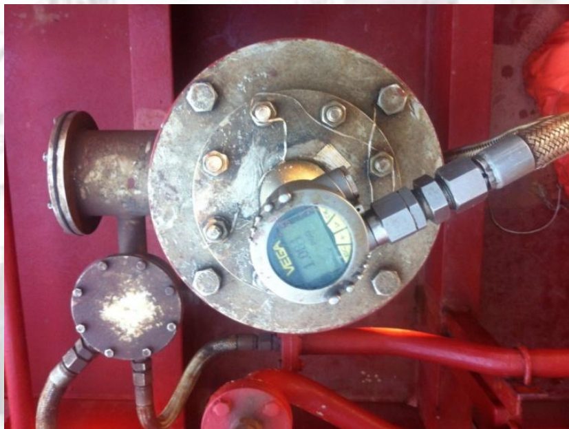
Imagen de un radar con software HANLA tipo MMCU-500, de la marca VEGA. (Archivo: Alfonso Fortuny).
