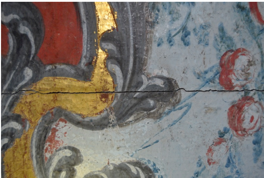
Imagen 55. Separación entre tablas que se hace visible en la cara externa. Fuente: de la autora.
