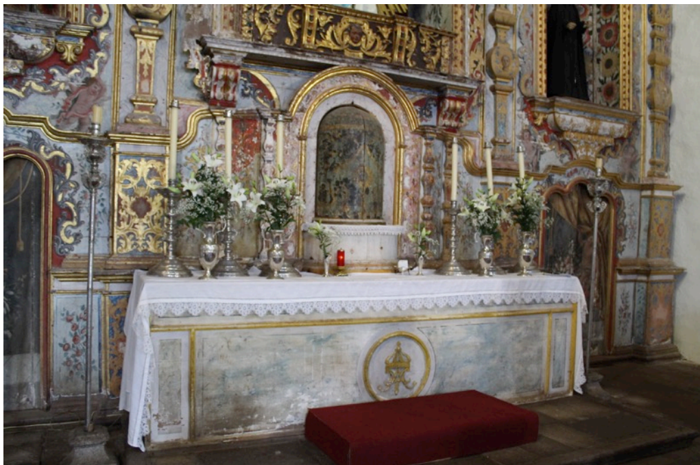
Imagen 46. Estado de conservación antes de la intervención. Fuente: Pablo Torres Luis.
