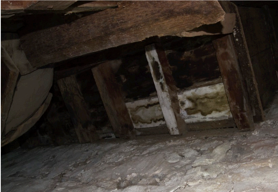
Imagen 50. Vigas apoyadas de la hornacina central. Ataque de microorganismos. Fuente: de la autora.
