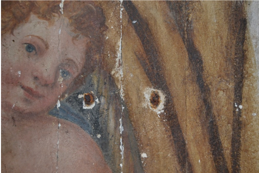
Imagen 54. Oxidación por clavos. Unión de maderas en las hojas de las puertas. Fuente: de la autora.
