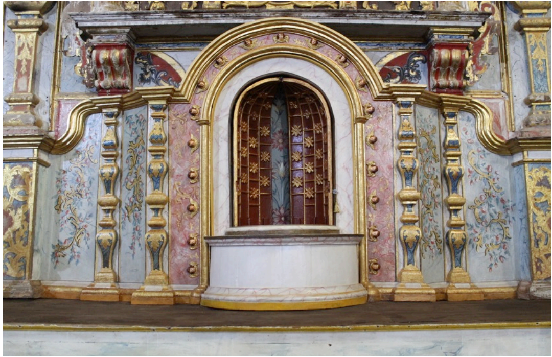
Imagen 49. Resultado final tras la intervención. Fuente: Pablo Torres Luis.
