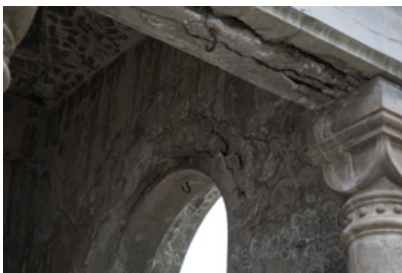
Img.10: Mausoleo, vista hacia el interior. Fotografía tomada en Mayo de 2017
