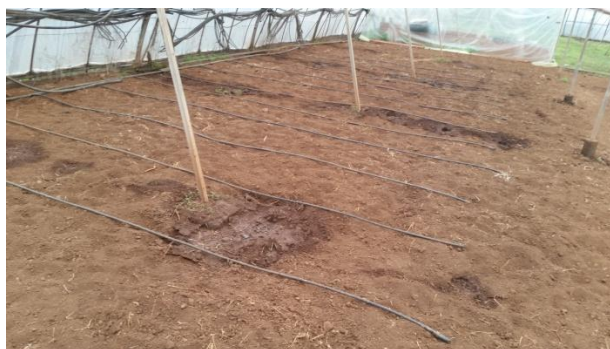
Foto nº18: Detalle del terreno labrado y con las tuberías colocadas.
