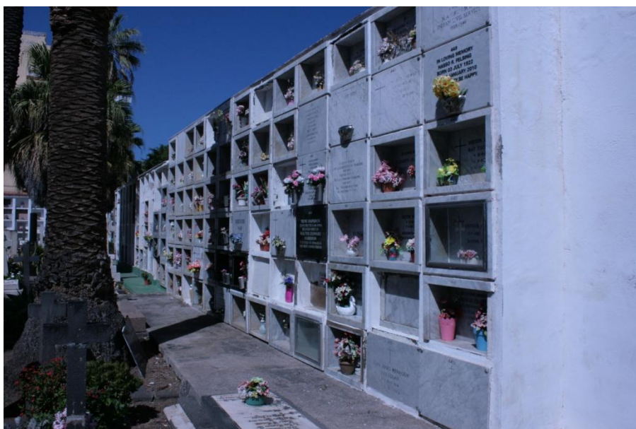
Figura 3. Detalle de uno de los muros con nichos adosados.
