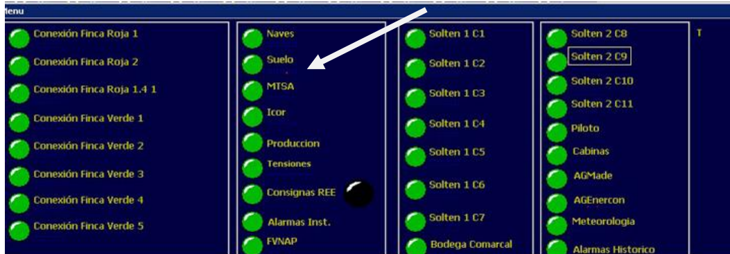
Figura 18: Pantalla de las plantas fotovoltaicas con una alarma
