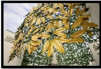
Figura 7. Detalle de la cúpula
