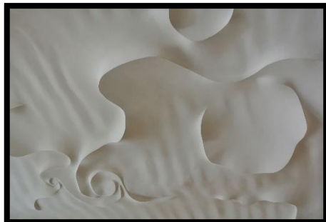
Figura 67. Ondulaciones del techo, rescatadas tras la remodelación que ordenó la señora Milá.
