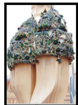
Figura 60. Detalle de una de las chimeneas ubicadas en la azotea de la Casa Milá.
