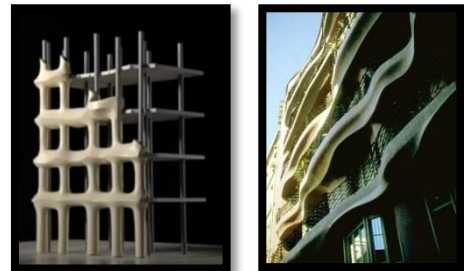
Figura 4. Estructura de la fachada y acabado final de la Pedrera.
