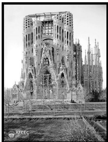
Figura 72. Fotografía de la construcción de la Fachada del Nacimiento
