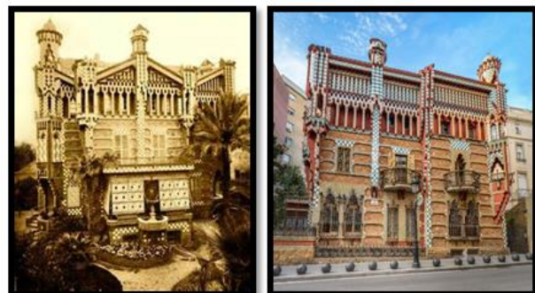
Figura 44. La casa Vicens, fachada original (izquierda) y remodelada (derecha).
