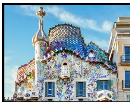
Figura 28. Recreación de colores del remate de la fachada de la Casa Batlló
