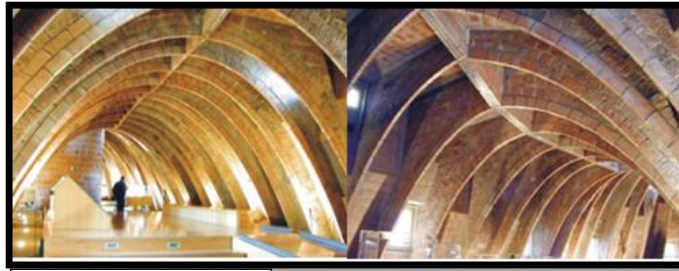
Figura 66. Superior: estructura interna de los arcos que forman el desván y mantienen la sinuosidad de la azotea (abajo)
