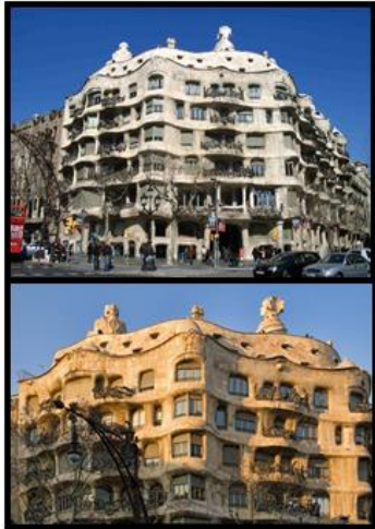
Figura 63. Arriba: vista general de la Casa Milà. Abajo: ejemplo de la diferencia de policromía de la fachada a diferentes horas del día.
