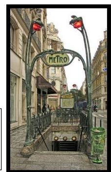
Figura 10. Ubicación actual de las lámparas de la boca de metro.
