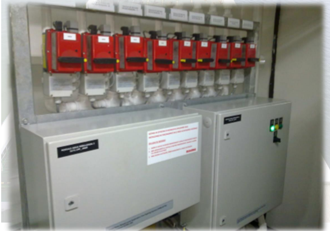
Ilustración 57. Panel de control remoto del sistema "Mini-Fog", situado en sala de máquinas. Fuente: Trabajo de campo.
