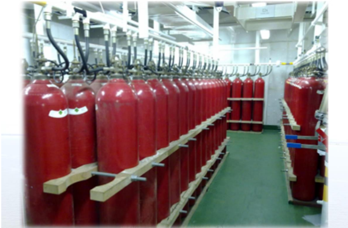
Ilustración 50. Botellones, local CO2, Cubierta 5 babor. Trabajo de campo.
