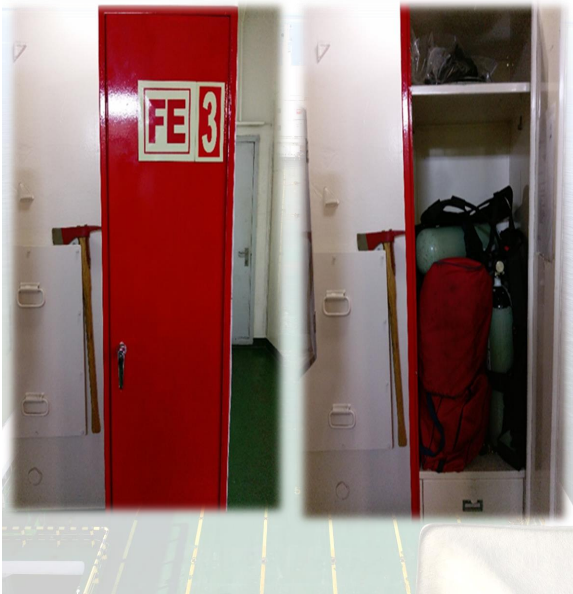
Ilustración 35. Estación de incendios número 3, situada a la entrada de la sala de máquinas. Trabajo de campo.
