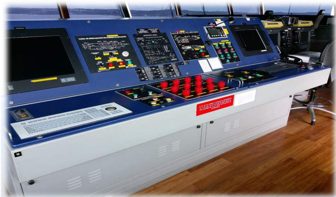
Ilustración 66. Vista general de una de las consolas de mandos del SFB. Fuente: Trabajo de campo.
