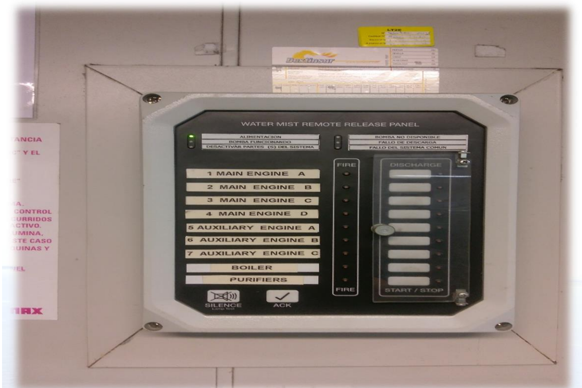
Ilustración 57. Panel de control remoto del sistema "Mini-Fog", situado en sala de máquinas. Fuente: Trabajo de campo.
