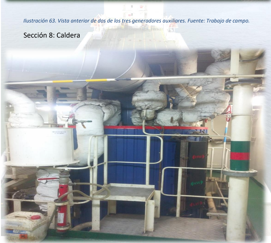
Ilustración 64. Parte alta de la caldera. Fuente: Trabajo de campo.
