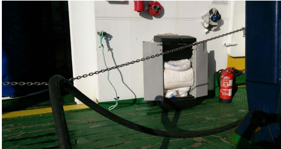
Ilustración 21. Absorbentes situados frente a la zona de toma de combustible. Fuente propia
