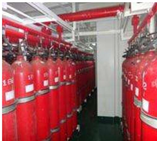
*Ilustración 25. Botellas del cuarto de CO<sub>2</sub>. Fuente: <http://www.monografias.com/trabajos96/informe-tecnico-pasantias-profesionales-bordo-del-buque-tanque-zeus/informe-tecnico-pasantias-profesionales-bordo-del-buque-tanque-zeus2.shtml>*
