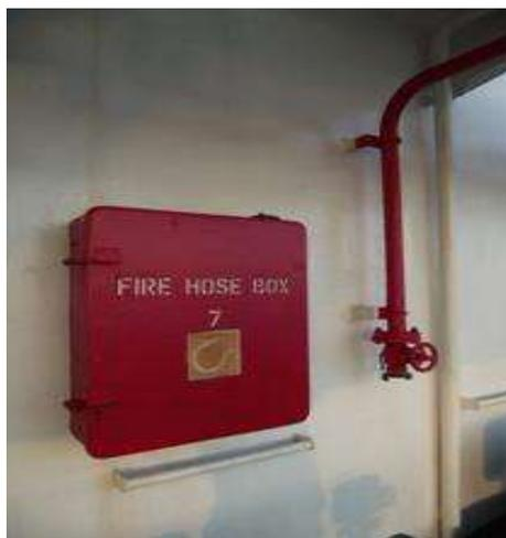
Ilustración 27. Hidrante. Fuente:<http://www.monografias.com/trabajos96/informe-tecnico-pasantias-profesionales-bordo-del-buque-tanque-zeus/informe-tecnico-pasantias-profesionales-bordo-del-buque-tanque-zeus2.shtml>
