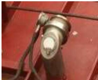
*Ilustración 10. Tank Radar. Fuente: Elaboración propia*
