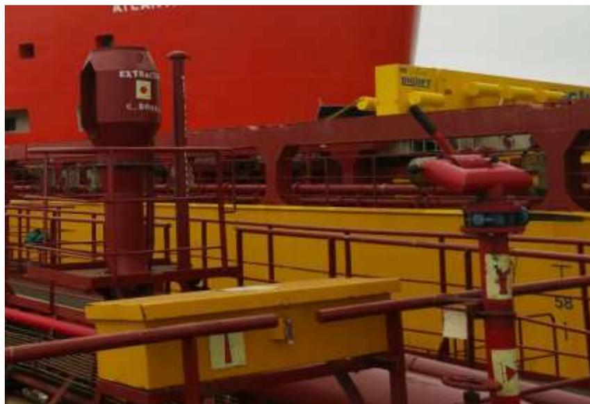
Ilustración 19. Extractor del cuarto de bombas. Fuente: Elaboración propia
