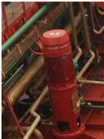
Ilustración 14. Bomba de carga. Fuente: Elaboración propia
