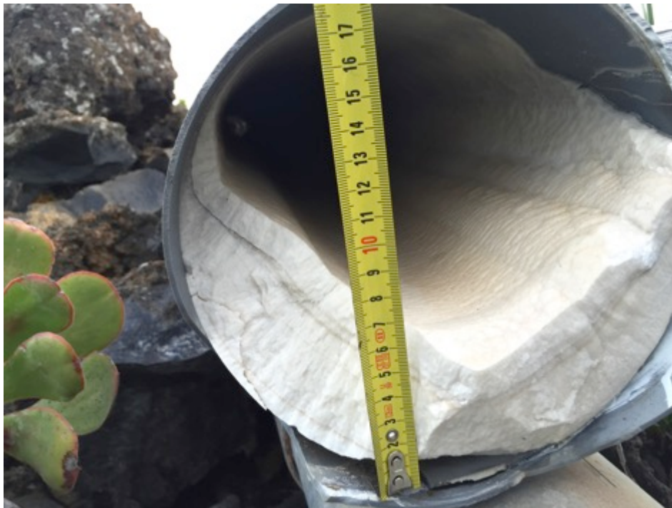
3. Tubo de PVC utilizado en la canalización del agua procedente de la galería.
