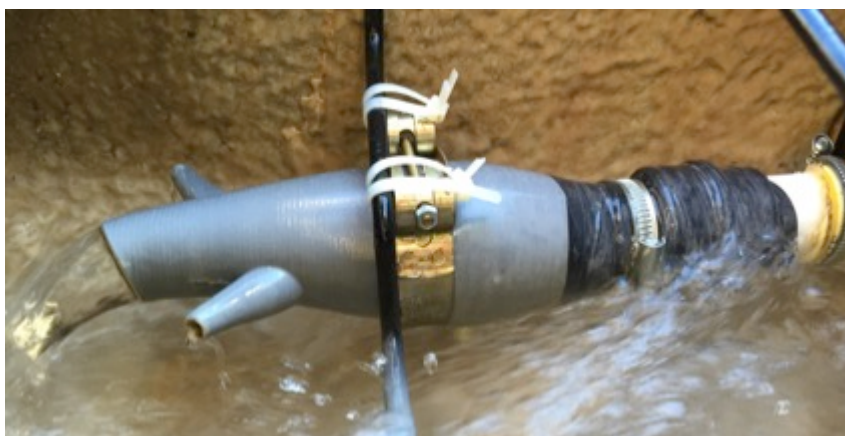
27. Molde PLA incorporado en la atarjea mediante una estructura metálica como soporte. El molde va acoplado con un sistema de anillas y abrazaderas a una manguera de llenado.
