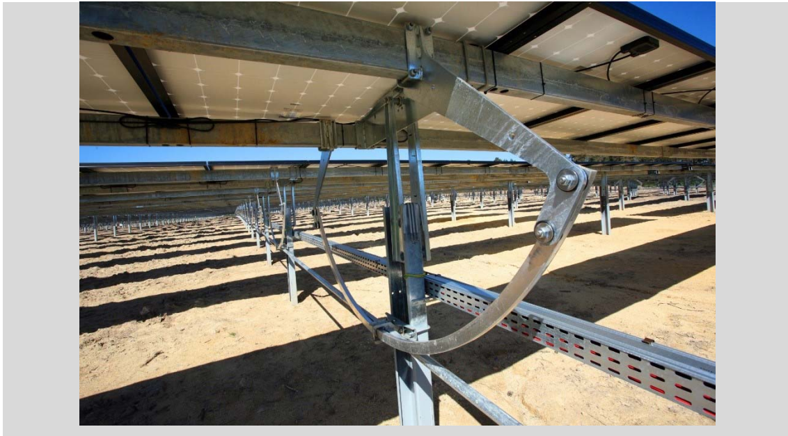
Imagen 10. Ejemplo de montaje del seguidor solar Exorack HZ
