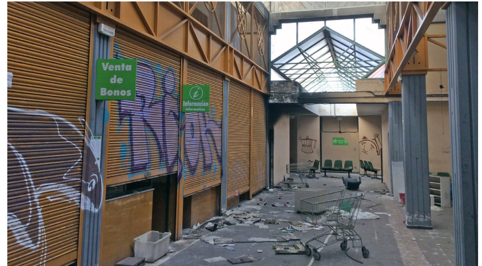
Figura 19. Estado de la sala principal de la estación
