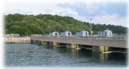
mantiene cerrado y se espera a que vuelva a subir la marea, se podrá volver a obtener electricidad abriendo las compuertas y llenando el depósito haciendo pasar el agua por las turbinas. Con este sistema se produce energía al subir y al bajar la marea. La producción de energía dependerá, pues, de la variación de la altura de la marea, de la frecuencia de las mareas, de la potencia de las turbinas así como de la capacidad del depósito.
