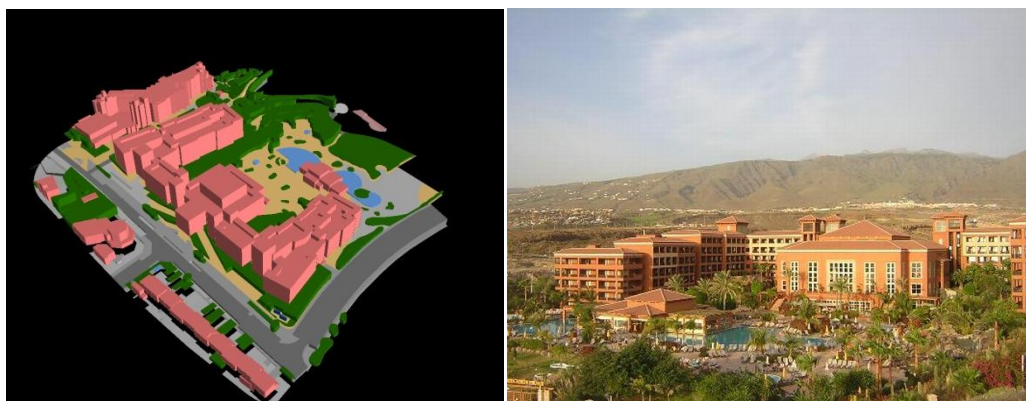
Figura 121.- Ejemplo de una edificación de alojamiento turístico horizontal. Hotel Costa Adeje Palace (1999) en Costa Adeje
