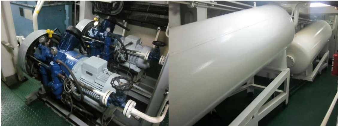
Ilustración 9 - Compresores de pistón a 30 bar y botellas de aire de los MMPP. Fuente: Trabajo de campo.
