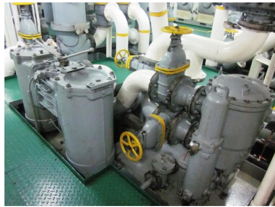
Ilustración 19 – Filtro dúplex y automático
