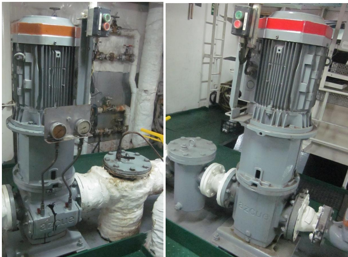
Ilustración 14 - Bomba trasiego FO y bomba trasiego DO. Fuente: Trabajo de campo.
