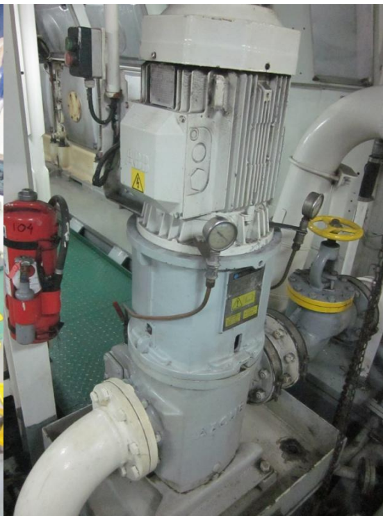
Ilustración 17 – Bomba de prelubricación
