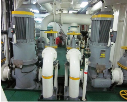
Ilustración 18 – Bombas de lubricación
