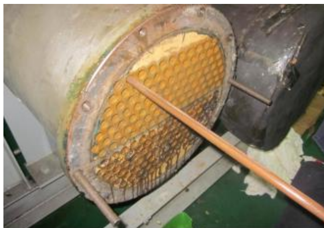
Ilustración 51 - Limpiando orificios condensador con una vara
