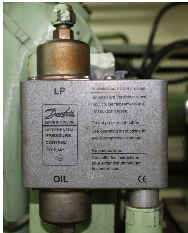
Figura 4.6: Presostato diferencial de aceite
