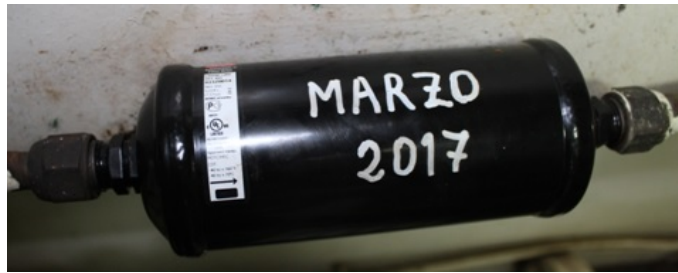
Figura 4.9: Filtro deshidratador
