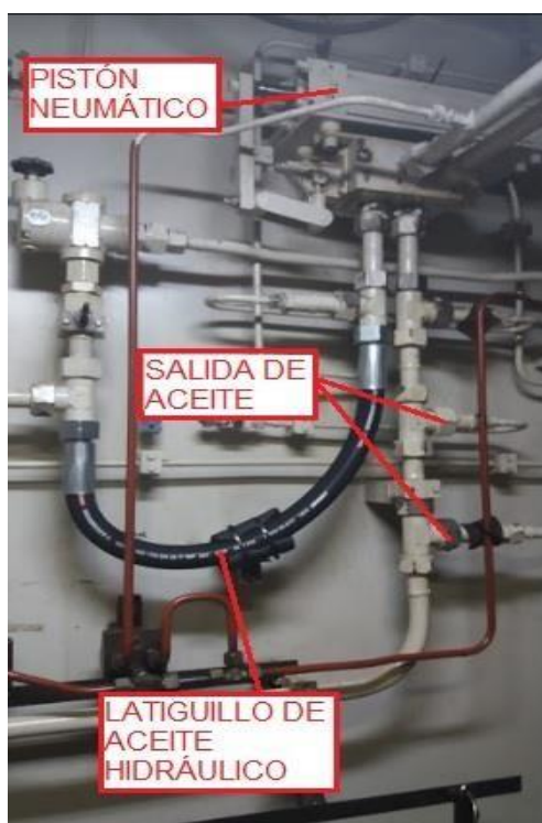
Ilustración n° 74 Línea de accionamiento y distribución.
