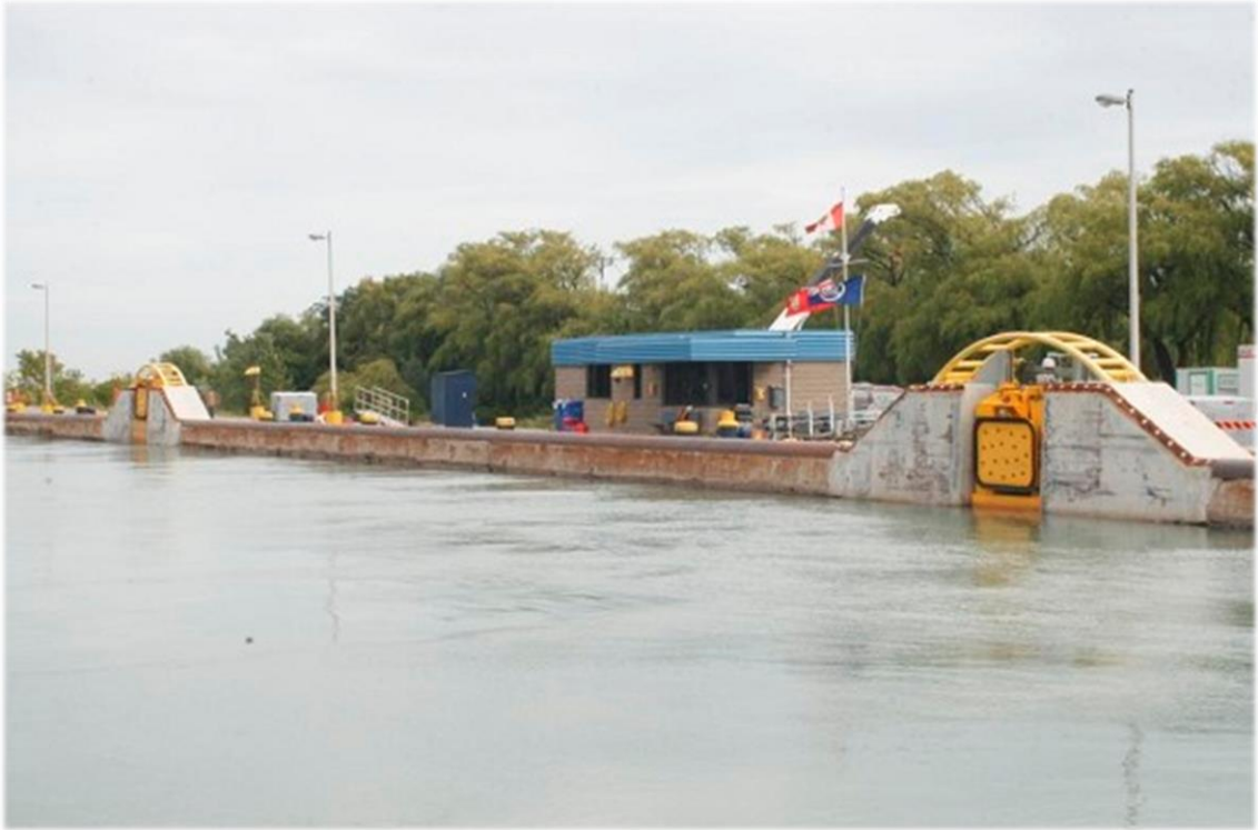
(5) Unidades independientes del sistema 200 LS que trabajan en conjunto.
