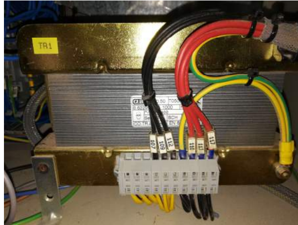
Figura 16: Transformador 400V/120V
