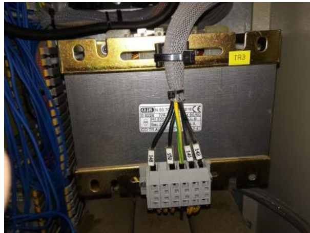
Figura 15: Transformador 400V/230V
