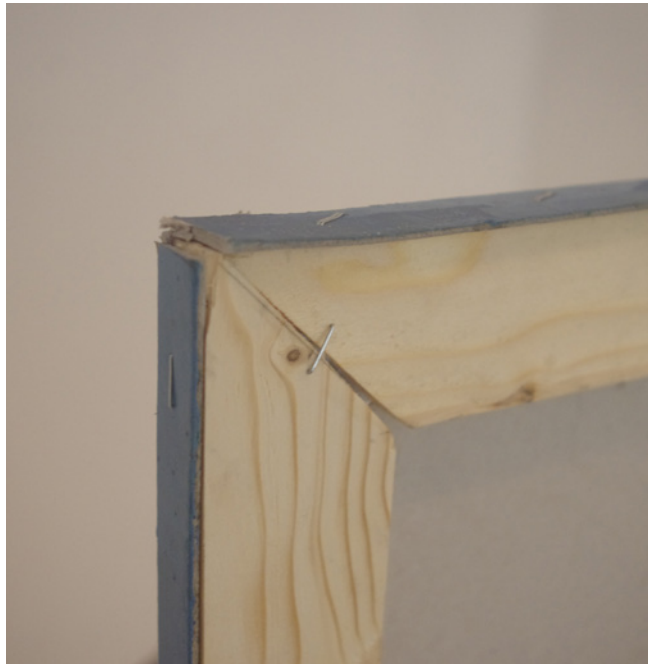
Detalles de la elaboración de los soportes “encartonados”.
