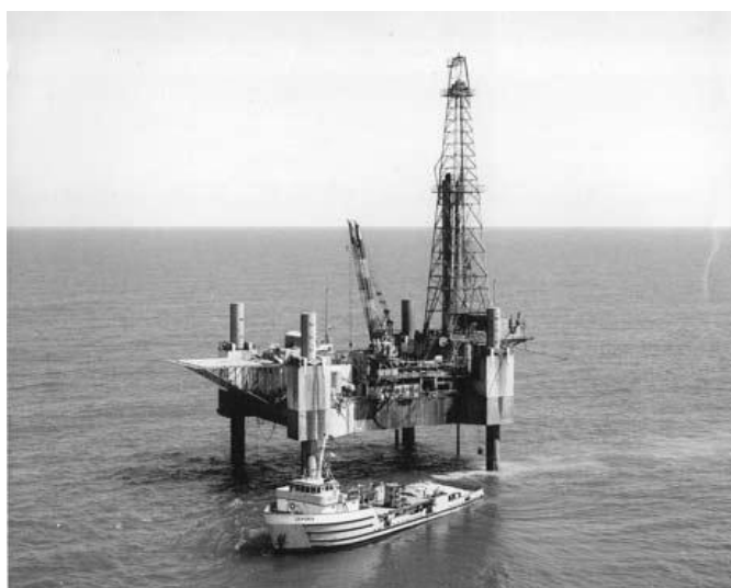
Fig. nº 6. Plataforma tipo Jackup “Vinegaroon” de Petrobras, 1971
