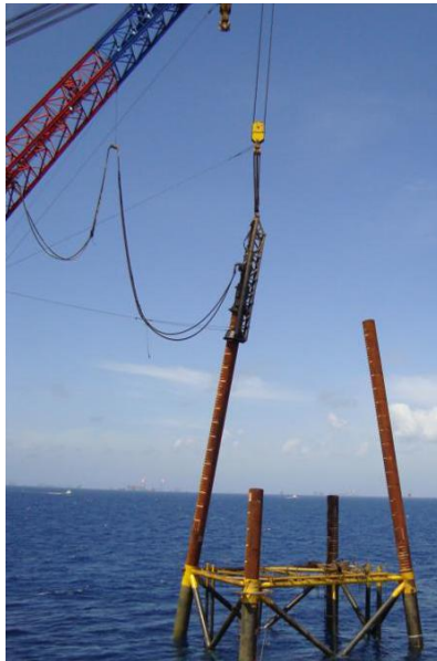
Fig. nº 10. Hincado de pilotes en plataforma tetrápoda
