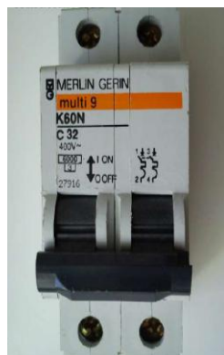
Ilustración 3: Interruptor magnetotérmico de 2 polos.
