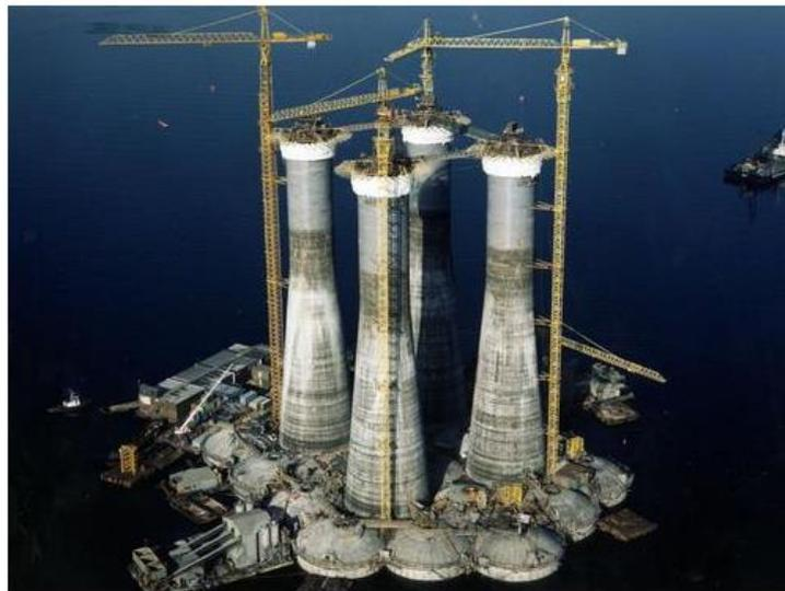
Ilustración 27. Construcción de los ejes de una plataforma Statfjord B. Fuente: [nom.nb.no/eng/The-Field/Statfjord-B/Building-the-concrete-GBS](http://nom.nb.no/eng/The-Field/Statfjord-B/Building-the-concrete-GBS)
