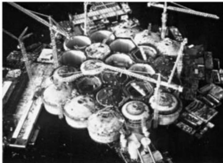
Ilustración 26. Construcción de cúpulas de la plataforma Statjord B GBS. Fuente: [Construction of Marine and Offshore Structures](http://Construction of Marine and Offshore Structures).
