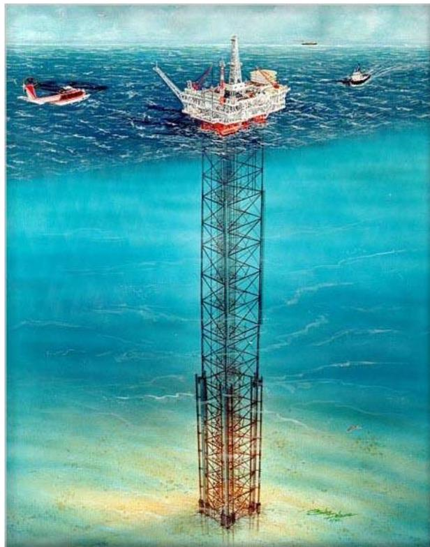
Ilustración 4. Proyecto Compliant Tower. Fuente: [www.budowle.pl](http://www.budowle.pl)
