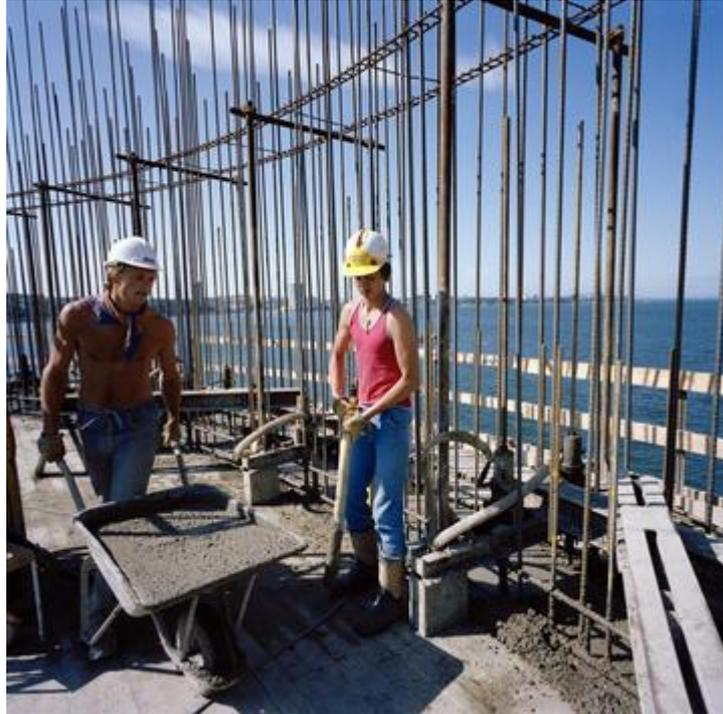
Ilustración 24. Operarios extendiendo el acero de refuerzo. Fuente: [nom.nb.no/eng/The-Field/Statfjord-B/Building-the-concrete-GBS](http://nom.nb.no/eng/The-Field/Statfjord-B/Building-the-concrete-GBS)
