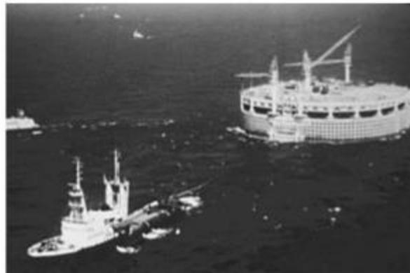
Ilustración 29. Remolque de Ekofisk (primer depósito de almacenamiento de combustible). Fuente: *Construction of Marine and Offshore Structures*.
