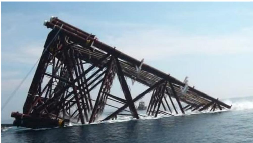
Ilustración 38. Deslizamiento de un jacket por una plataforma de lanzamiento. Fuente: [www.youtube.com/watch?v=WnwgFjnWttg](http://www.youtube.com/watch?v=WnwgFjnWttg)
