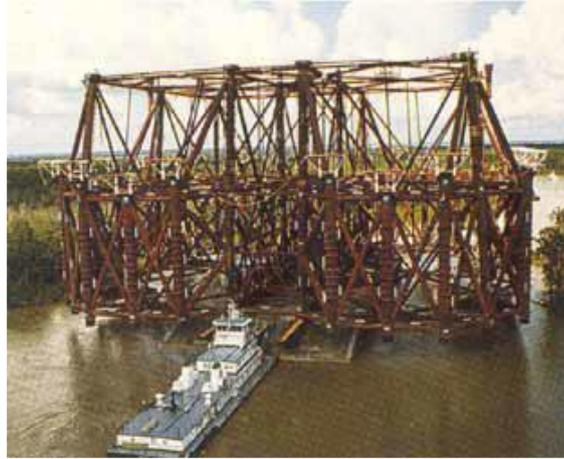
Ilustración 36. Parte inferior de la plataforma Cognac. Fuente: [www.southampton.ac.uk](http://www.southampton.ac.uk)
