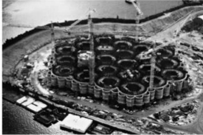
Ilustración 22. Base de la estructura de hormigón en construcción. Fuente: [Construction of Marine and Offshore Structures](#).
