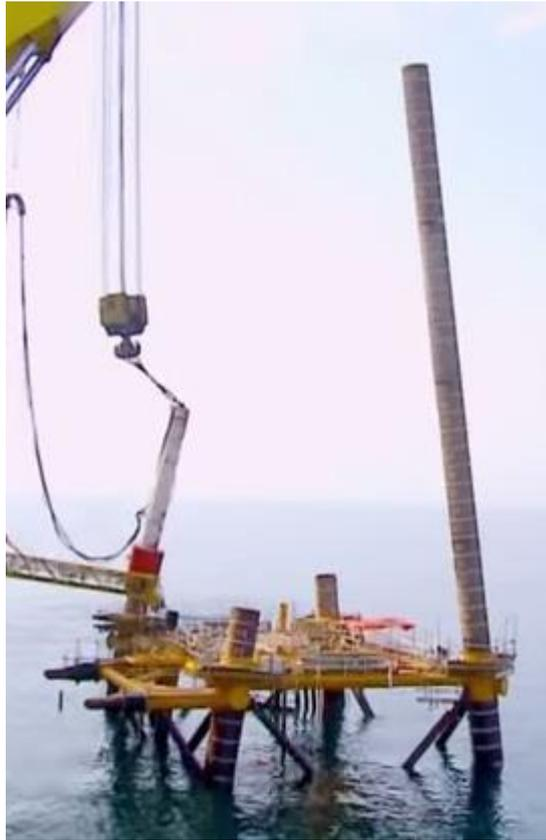
Ilustración 47. Introducción de los pilotes en los orificios. Fuente: [www.youtube.com/watch?v=WnwgFjnWtg](http://www.youtube.com/watch?v=WnwgFjnWtg)
