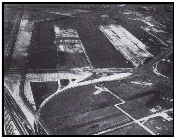
Ilustración 11: Construcción de las dársenas del sur del puerto de Eemhaven. (Fuente: [1])
