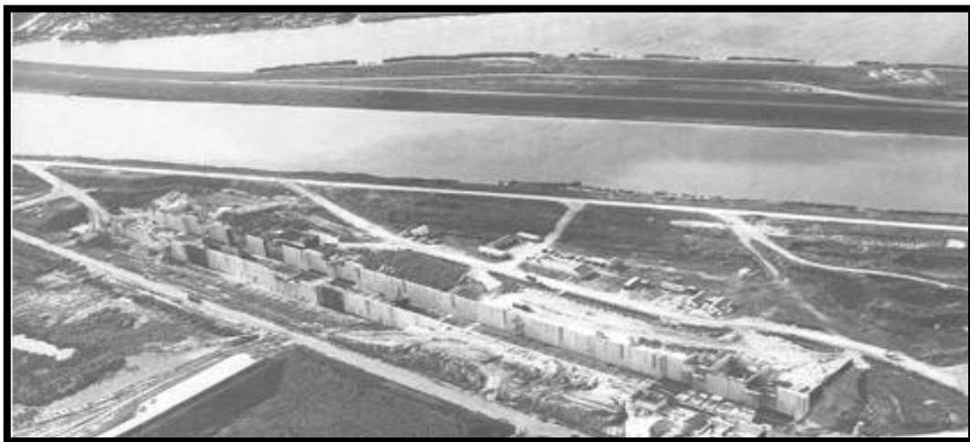
Ilustración 13: Parte del canal Hartel a la altura de Roozenburg.
