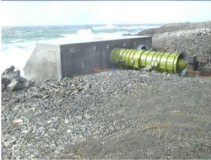
Figura 2.16: Instalación real Islay-Escocia, 2001 (OWC) [Heath,2008]
