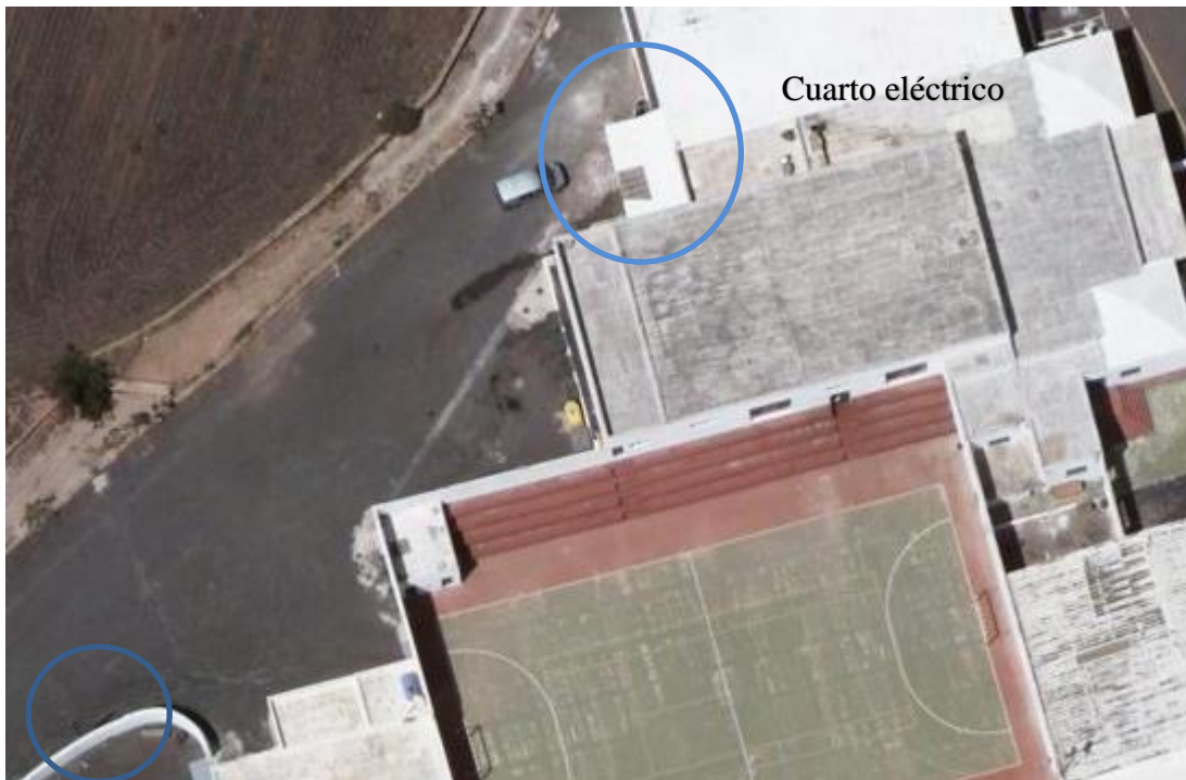
Ilustración IV Situación Cuarto Eléctrico
