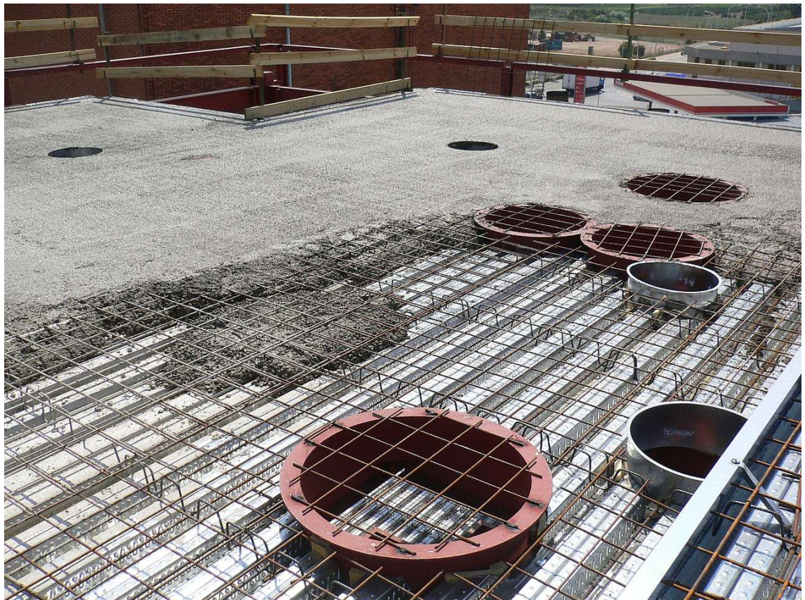
Construcción de un forjado colaborante. Fuente: Wikipedia.
