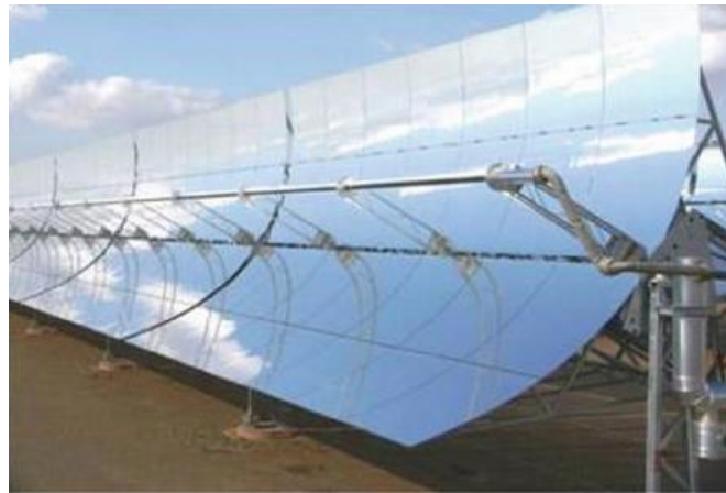
Fig. 17: Lazo o fila de captadores cilindro-parabólicos modelo Eurotrough [11]
