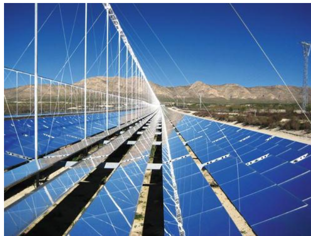
Fig. 10: Captador Fresnel lineal en la central de Puerto Errado [7]
