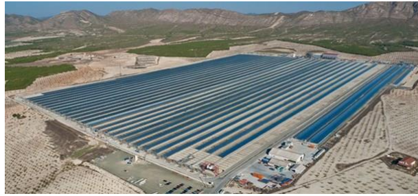
Fig. 11: Vista aérea de la central de Puerto Errado [7]
