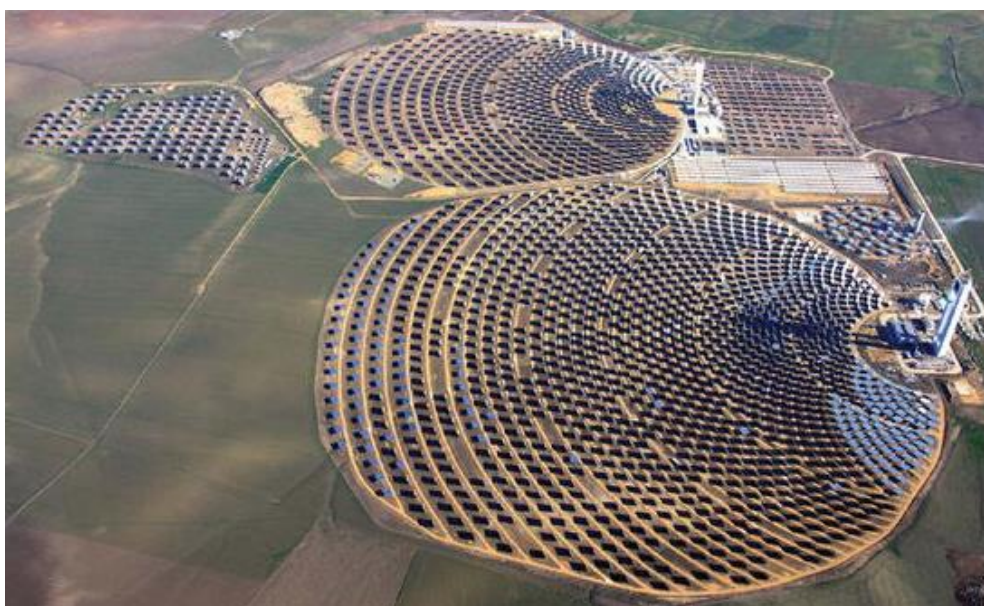
Fig. 8: Imagen aérea de las centrales PS10 y PS20 [6]
