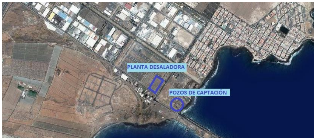
Figura 14: Colocación inicial de las EDAM y del sistema de captación (Fuente: Grafcan)
