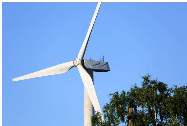
Figura 15: Imagen real del aerogenerador D6 62/1250kW de DeWind (Fuente: www.en.wind-turbine-models.com )
