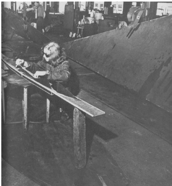
Fig.12. Proceso de ejecución en el taller de Dallas, Texas.
