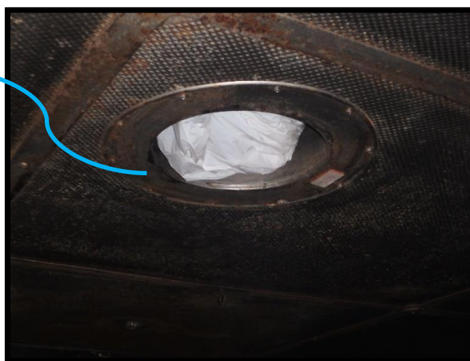
Ilustración 8. Cubrir detectores para el ejercicio de drencher. Fuente: Trabajo de campo.
