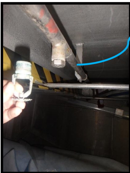
Ilustración 10. Taponamiento de un drencher. Fuente: Trabajo de campo.
