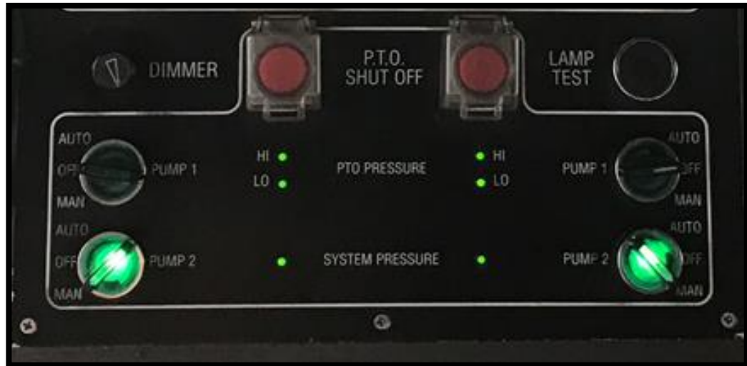
Ilustración 52. Panel de bombas hidráulicas. Fuente: Trabajo de campo.
