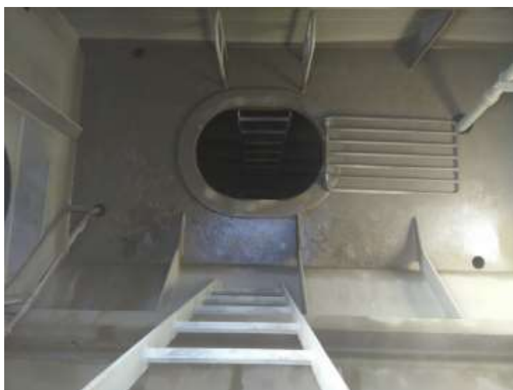
Ilustración 49. Entrada Tanque de Lastre. Fuente: Trabajo de Campo
