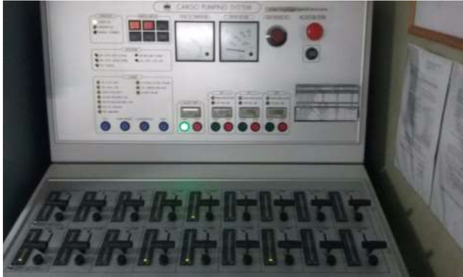
Ilustración 18. Unidad de Control Remoto FRAMO. Fuente: Trabajo de Campo
