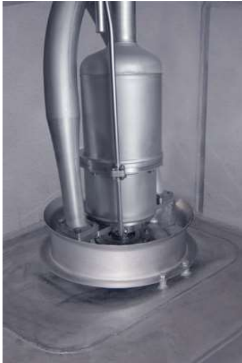
Ilustración 21. Bomba de Descarga en el Interior del Tanque. Fuente: Manual del FRAMO
