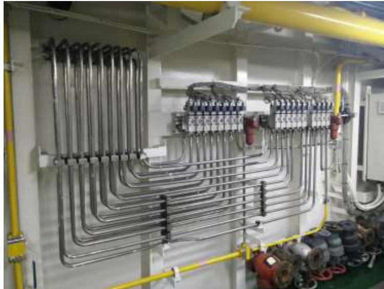
Ilustración 16. Conjunto Pilotadas Local del FRAMO. Fuente: Trabajo de Campo
