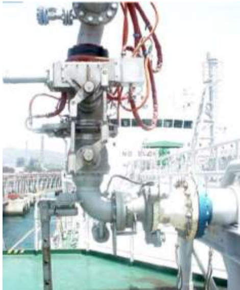
Ilustración 42. Conexión Manifold Buque con Brazo Terminal. Fuente: Cepsa
