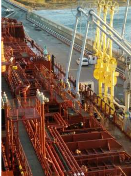
Ilustración 43. Brazos Terminal Motril en Operación de Descarga. Fuente: Trabajo de Campo
