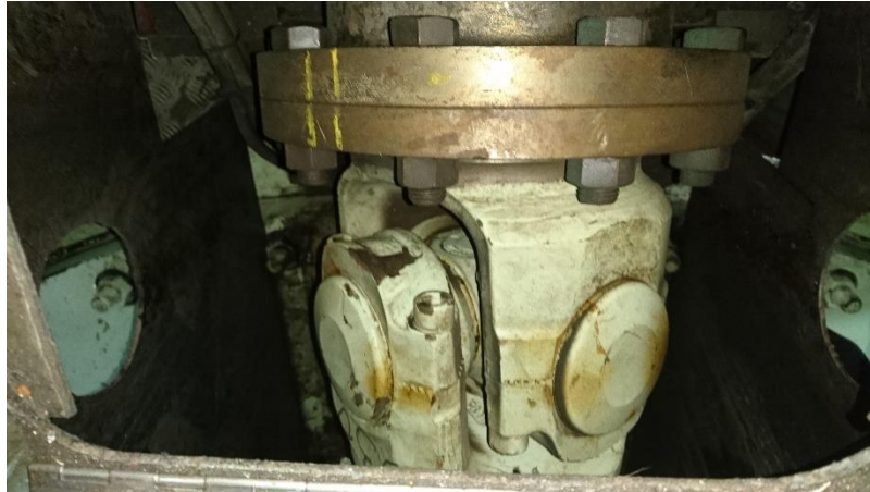
Figura 22. Articulación del eje. Fuente: Trabajo de campo.
