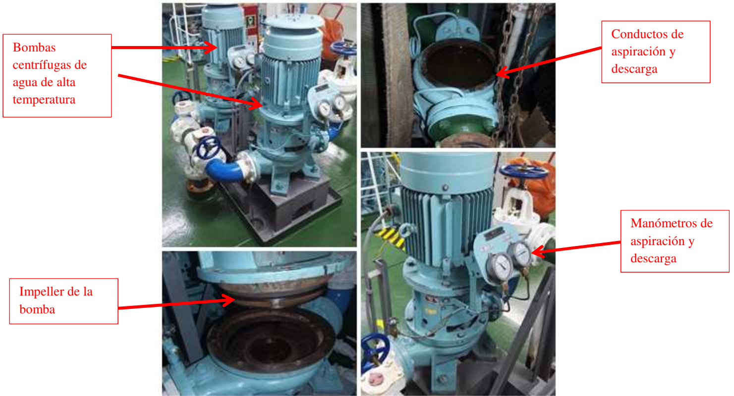
Ilustración N°41. Bombas centrífugas de alta temperatura durante mantenimiento
