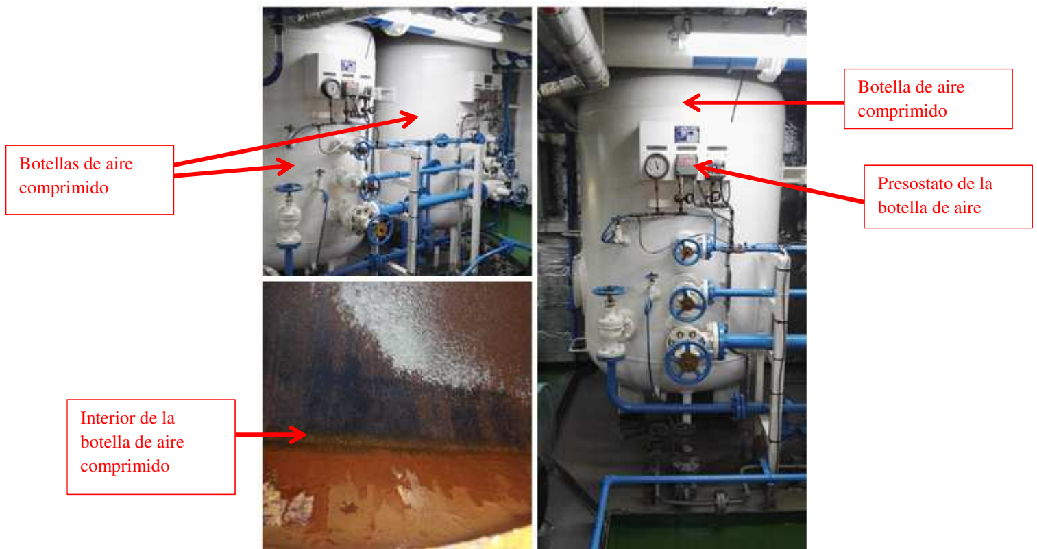
Ilustración N°48. Botellas de aire de arranque
