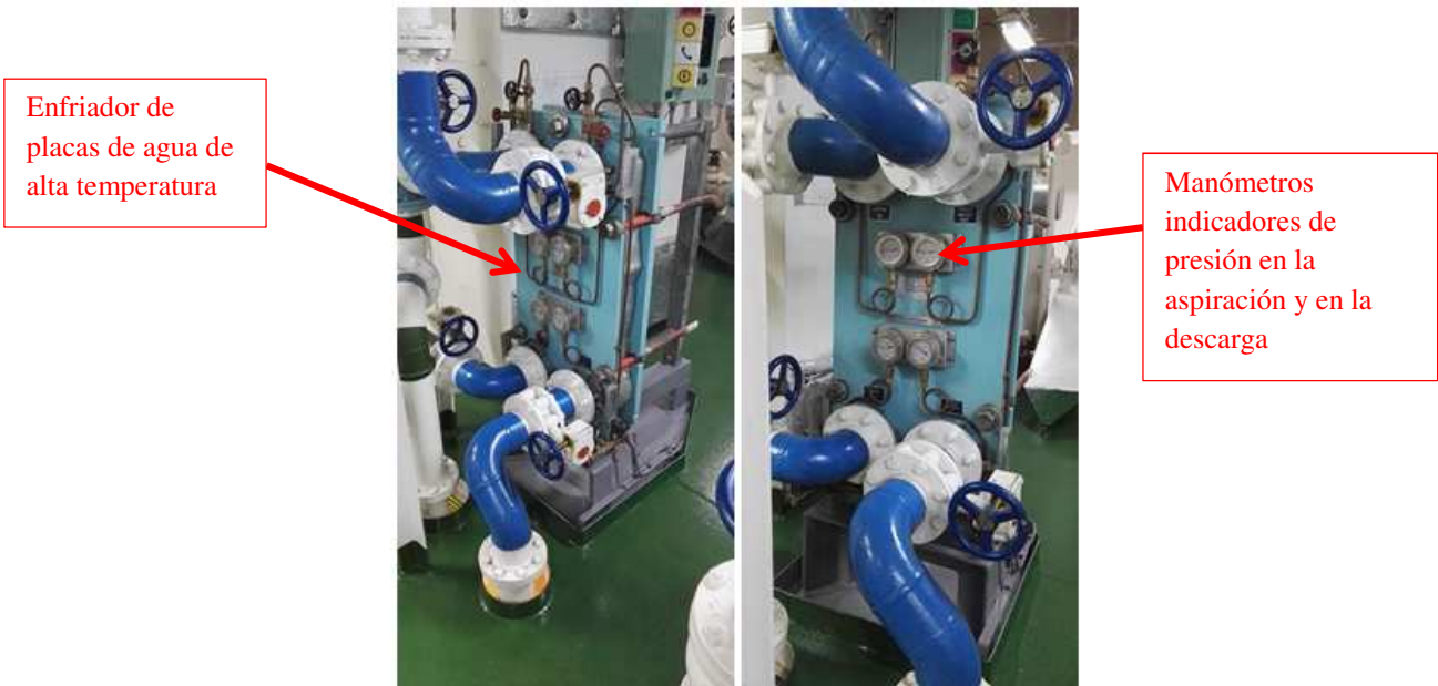
Ilustración N°44. Enfriador de placas de agua de alta temperatura
