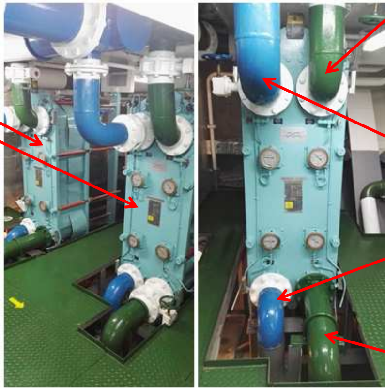
Ilustración N°29. Enfriadores de agua de baja temperatura
