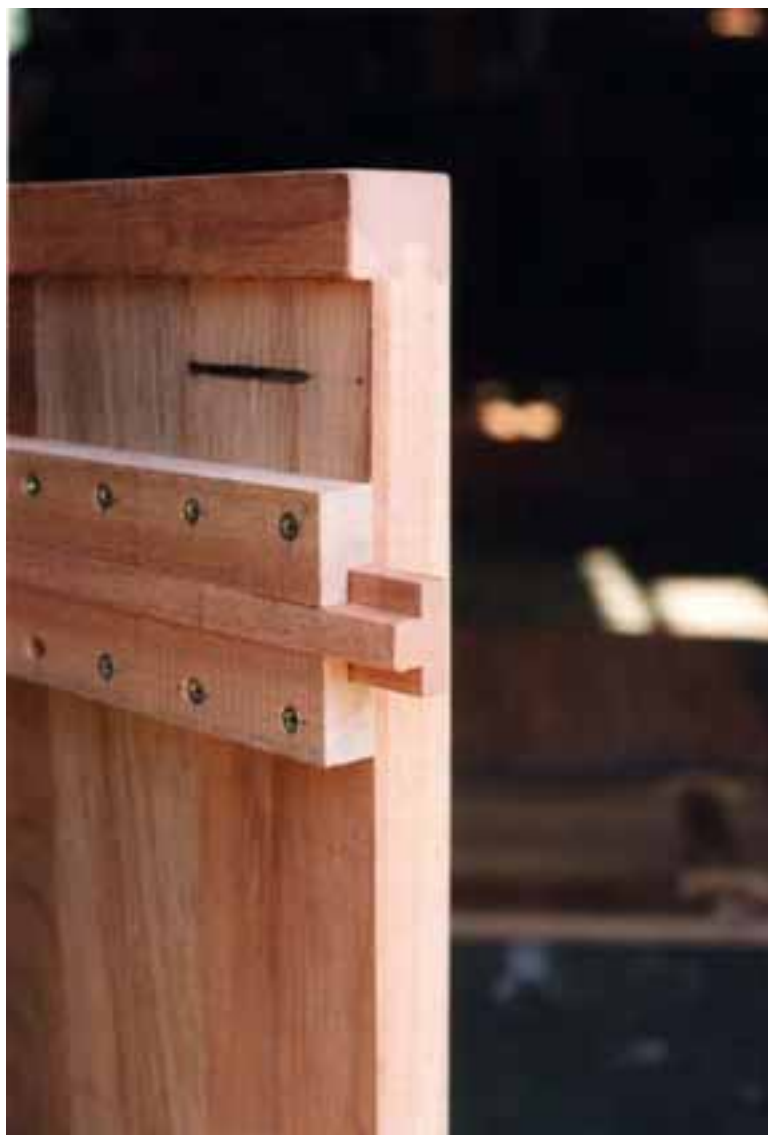
Fig. 4.37. Barrote en forma de T superpuesto.
