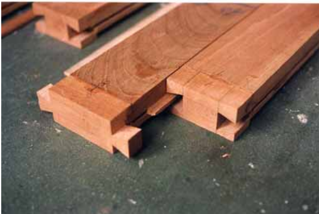
Fig. 4.38. Solución original de ensamble en el tope por colas de milano y ranura con lengüeta postiza.
