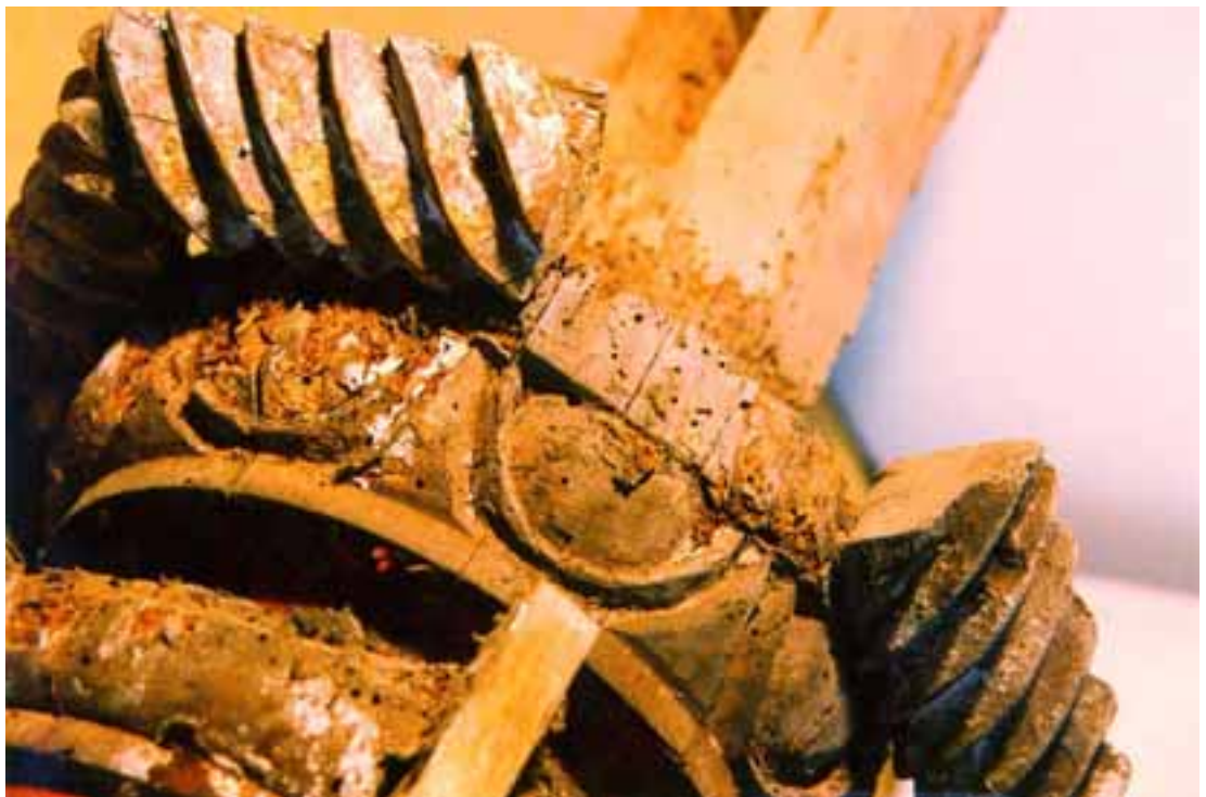
Fig. 5. 25. Efectos del ataque de coleópteros, en la pieza ornamental del artesanado de la iglesia de Tacoronte, Tenerife.
