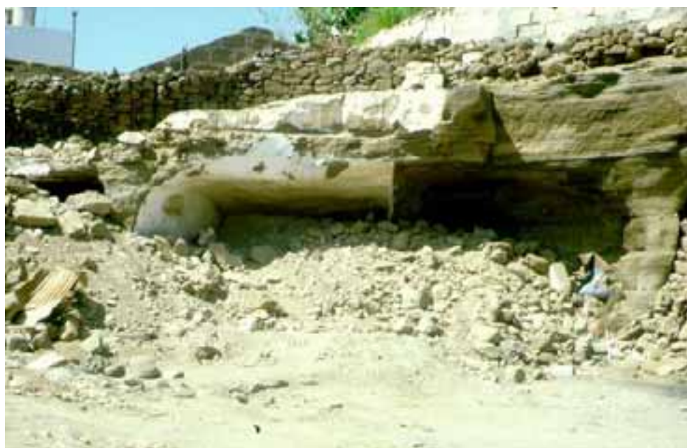
fig. III.209 BARRIO DEL HOSPITAL Vista de una de las cuevas, sepulcrales, que el resto del poblado en fechas cercanas a nuestra visita, por el propio ayuntamiento; presenta un enjambado blanco de factura reciente y una alcena excavada.
