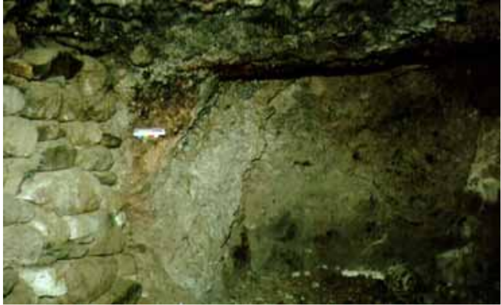
fig. III49 C DEL RECO PINTADO Vista de la dependencia izquierda y parte de la sala principal dividida por un muro de piedras; junto a este último, en la pared izquierda de la sala, se conservan restos de pintura roja.
