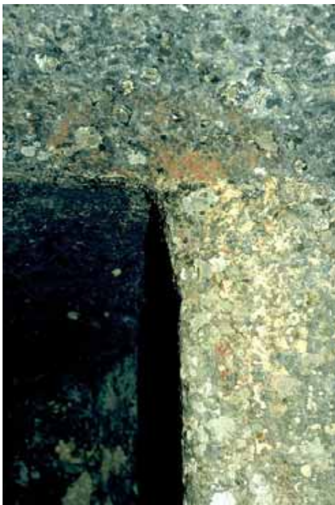
fig. III301 C DE LAS BRUJAS 4 Esquina superior derecha de la dependencia de ese mismo lado, apreciándose restos de pintura roja y blanca de las capas inferiores.
