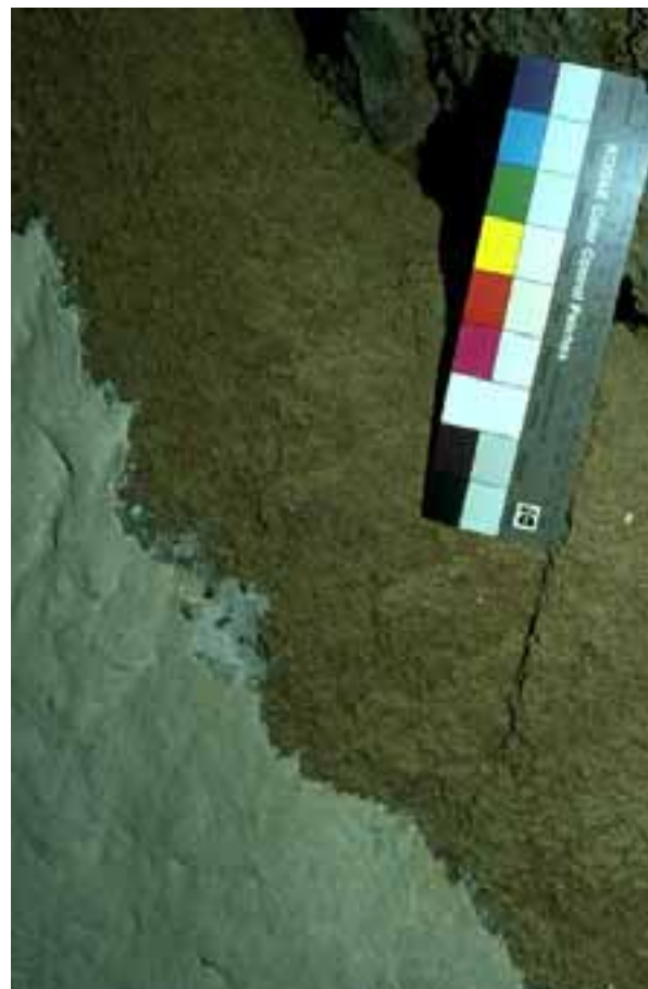
fig. III33 BRBQUEC 3 Detalle del acabado final de la pintura. Se aprecia también la cobertura gris de una capa previa que pudo aplicarse como sellador del soporte.
