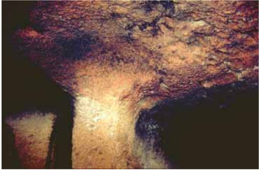
fig. III187 C. DE LA FURNA Vista de una parte del techo pintado junto a la dependencia. En esta zona los límites de la aplicación de la pintura se encuentran bien definidos.
